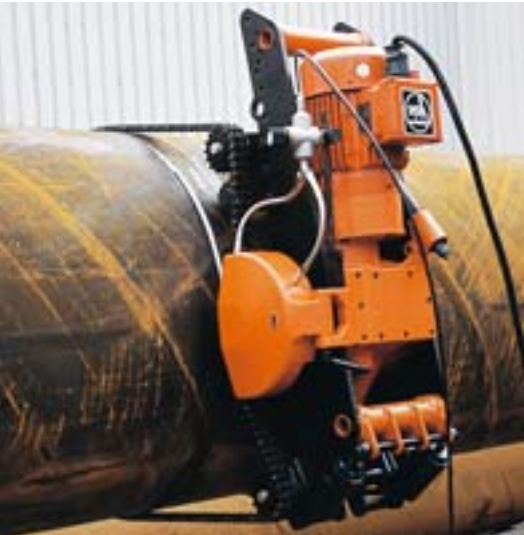
При строительстве трубопроводов.
