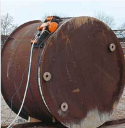
При сооружении резервуаров.
