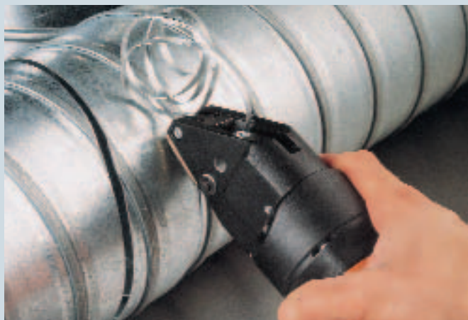
Резка труб, фальцованных намоткой
